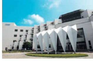
Tainan Fabrika (Elmas Sınıfı Yeşil Bina)
